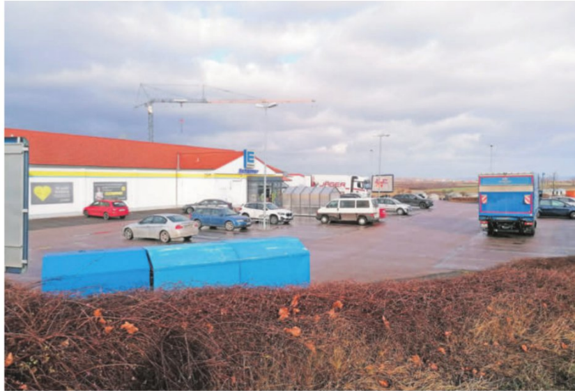
Der Edeka-Markt im Süden von Burgbernheim wird im kommenden Jahr abgerissen und neugebaut. Foto: Katrin Müller
